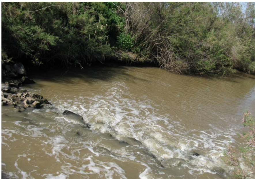
תמונה 10. מפלון בנוי אבן לקט מקומית, מורד הגשר האירי בסמוך לברכות נשר.
