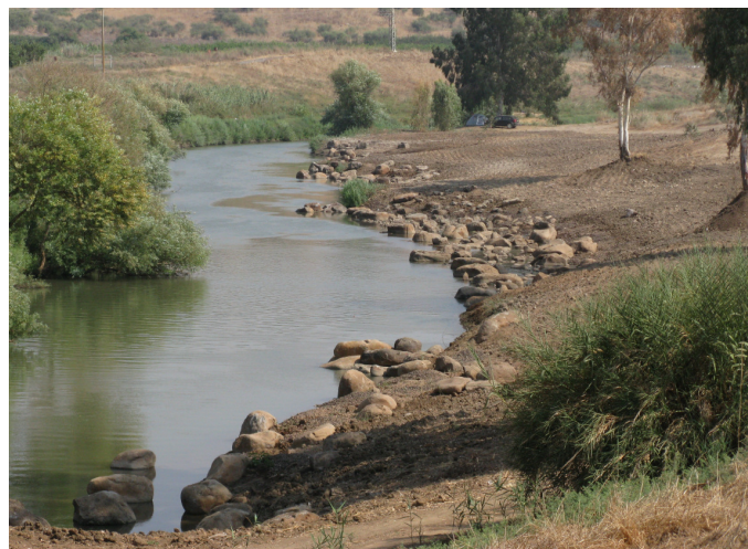
תמונה 9. הגברת הטרוגניות האפיק באמצעות אבנים טבולות, מורד גשר הפקק בירדן.
