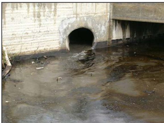
תמונה 13: מוצא הניקוז ממנו זרם המזוט לנחל גדורה
