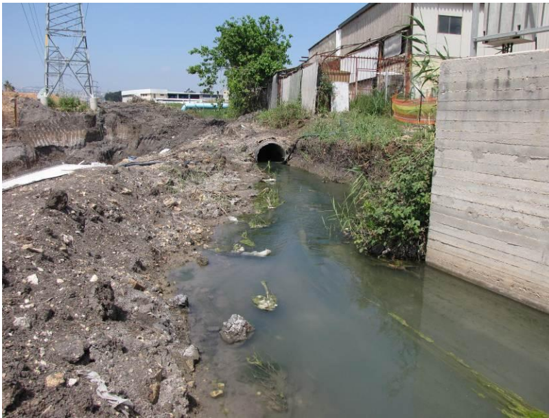
תמונה 10: מעביר מים ארעי והפרב של תואי הנחל בגשר סולל בונה
