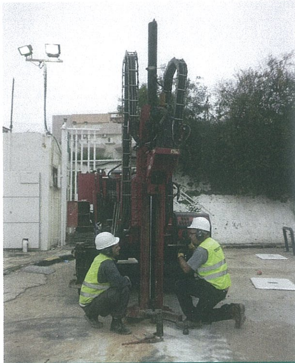
סקר קרקע בתחנת דלק. חברת LDD טכנולוגיות מתקדמות
